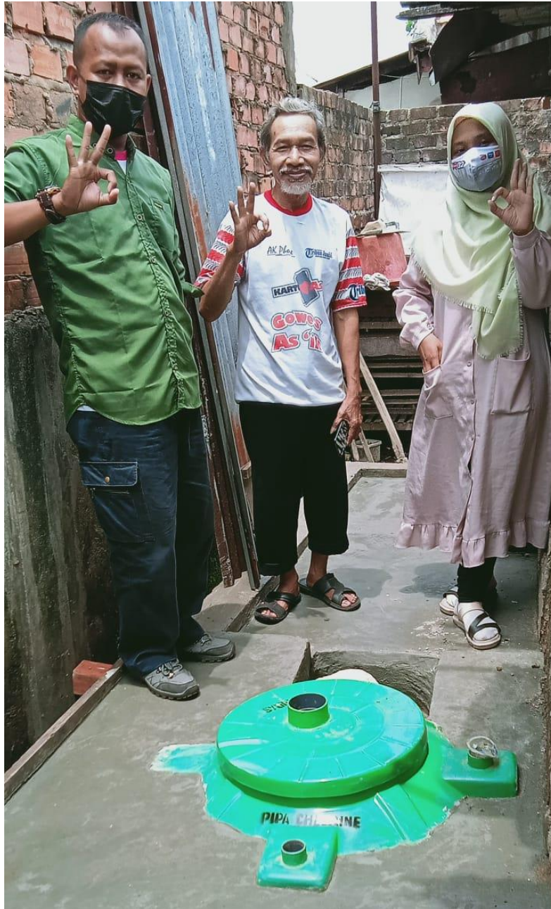
Gambar 5. Kondisi Pasca Pemasangan Salah Satu IPAL di Rumah Warga
