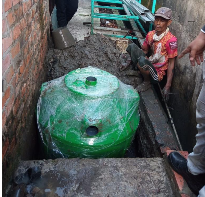
Gambar 3. Proses Pemasangan Salah Satu IPAL di Rumah Warga
