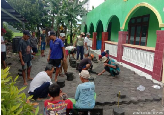
Gotong royong pemasangan paving oleh masyarakat
