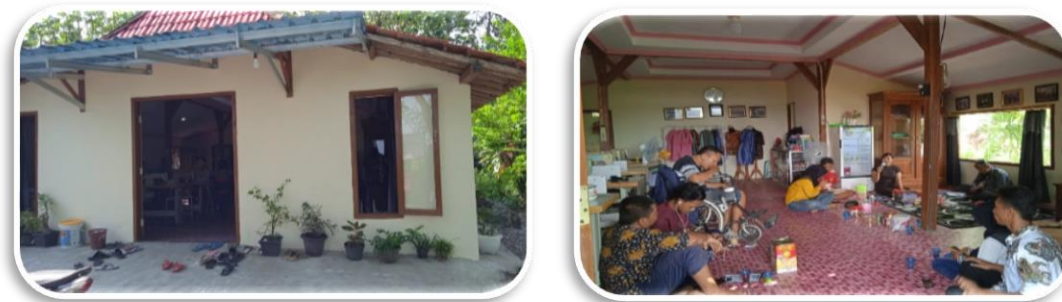
Foto 2. Workshop Kresna Patra Sesudah Renovasi
