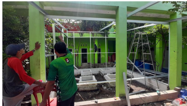
Gambar 5. Proses pembangunan bengkel Pertamina Sahabat Nelayan
